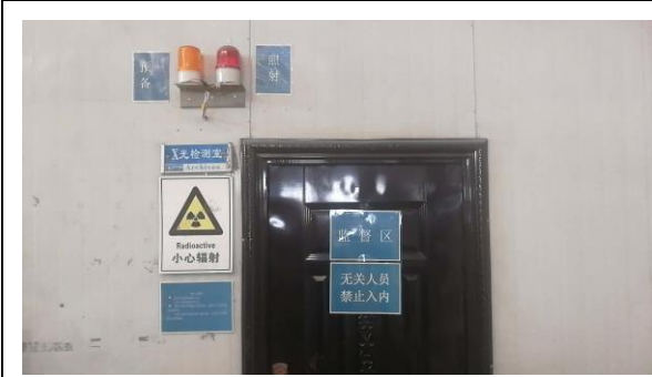
图 6-1 X 光检测室门口电离辐射警告标志、警示灯
