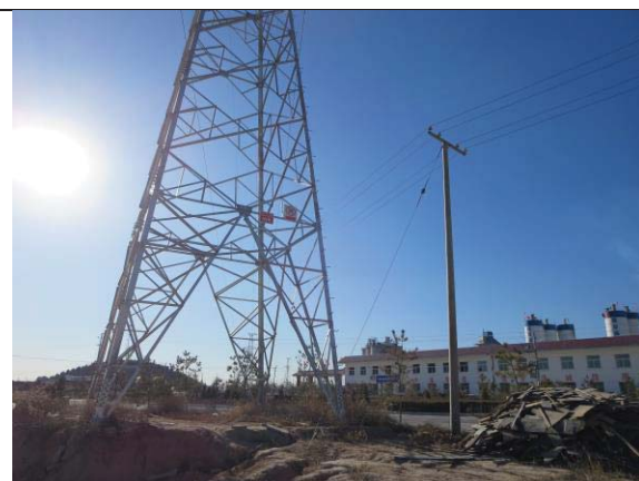
5 号塔基地面恢复情况
