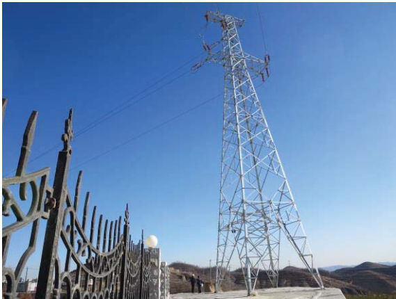
7 号塔基及地面硬化情况
