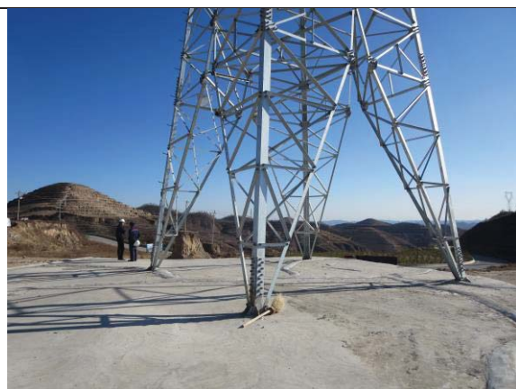
7 号塔基地面硬化情况
