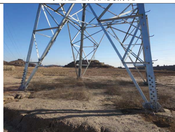
1 号塔基地面恢复情况
