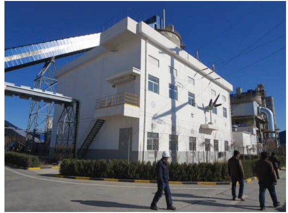
米脂冀东水泥有限公司综合配电楼（镜像 SE）
