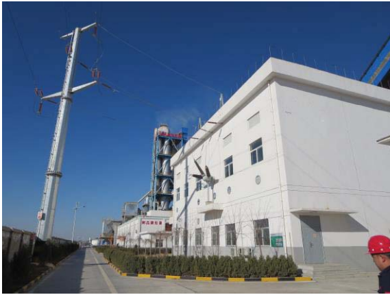
8号塔基及电源进线口
