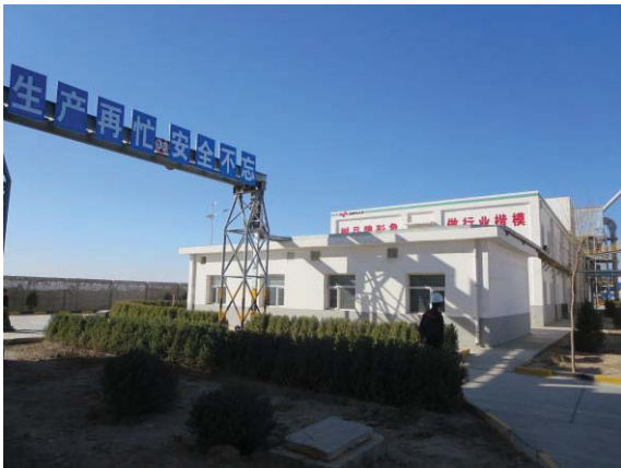
变电站南侧空压站
