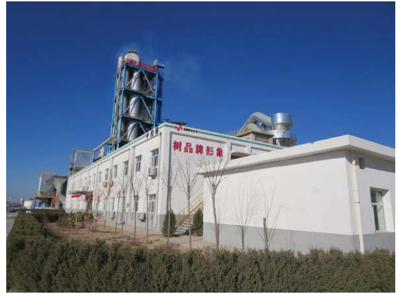
变电站北侧小磨房及中控楼
