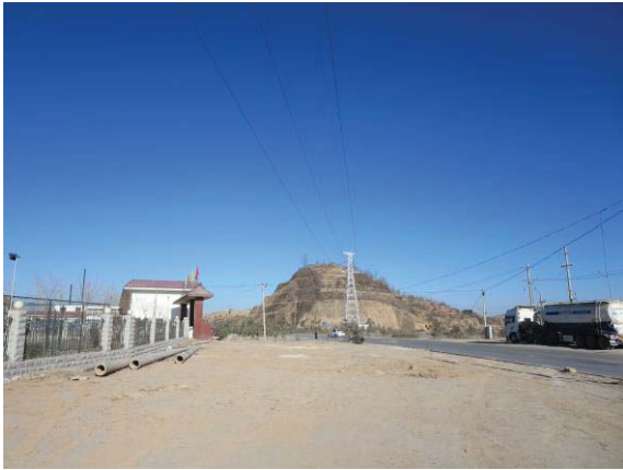
5 号塔基及陕西瑞龙商砼有限公司办公楼
