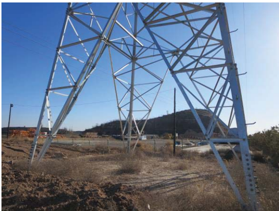
4 号塔基及植被恢复情况
