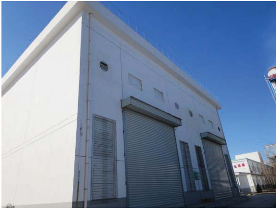
米脂冀东水泥有限公司综合配电楼（镜像 SW）
