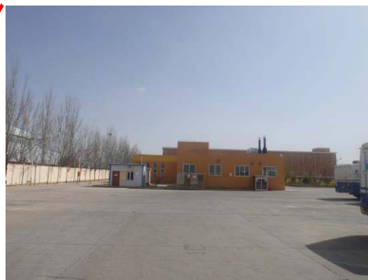
拟建项目南侧锅炉房及职工食堂 (镜像: S)
