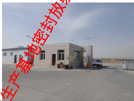
拟建项目西侧门卫室及库房 (镜像: N)
