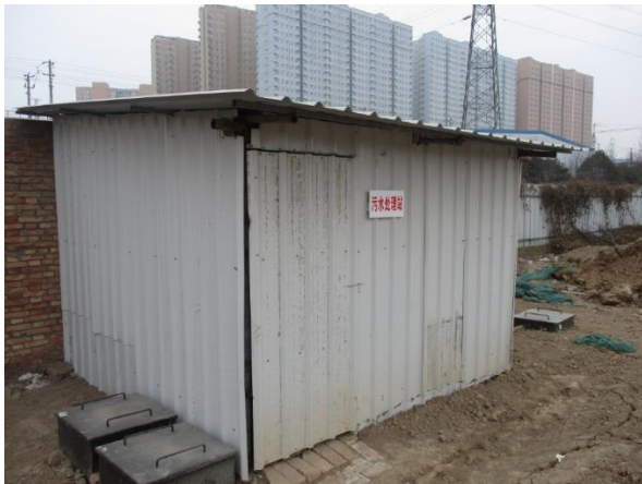
项目污水处理站
