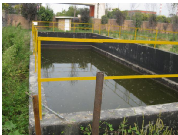
项目事故应急池
