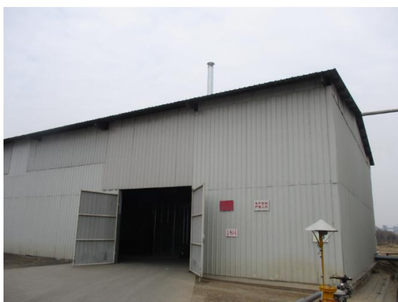
项目投料粉尘排气筒
