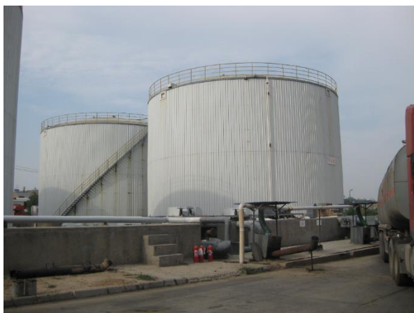
项目罐区围堰
