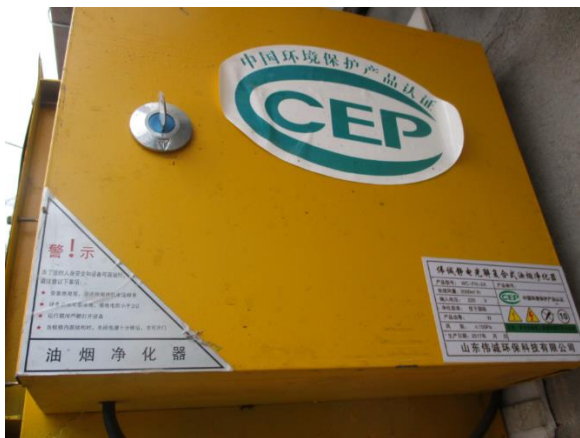
项目食堂油烟净化器
