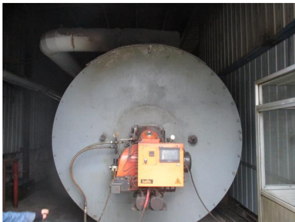
项目在用导热油炉及燃烧器
