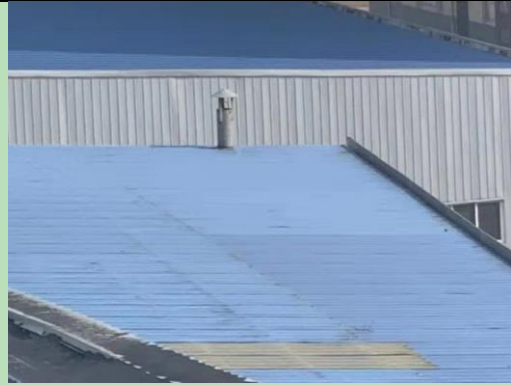
锅炉排气筒（外部）
