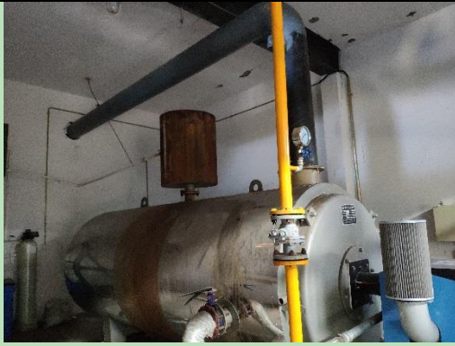
锅炉排气筒（内部）
