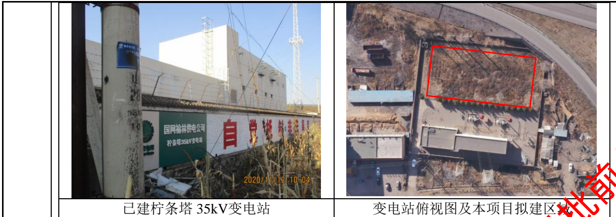
图2-1 柠条塔35kV变电站现状照片
