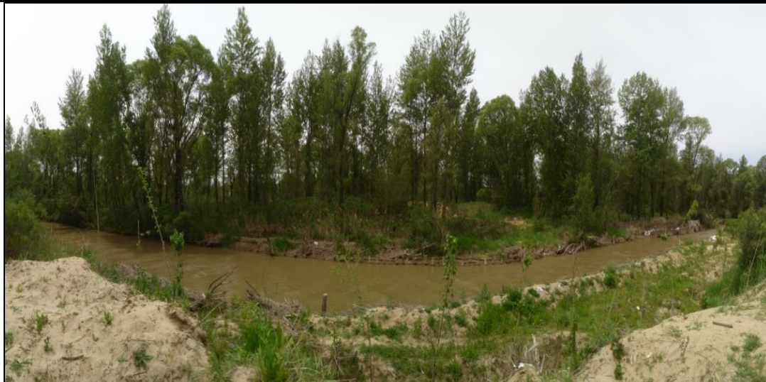
图 3-3 工程跨越榆溪河处现状照片
