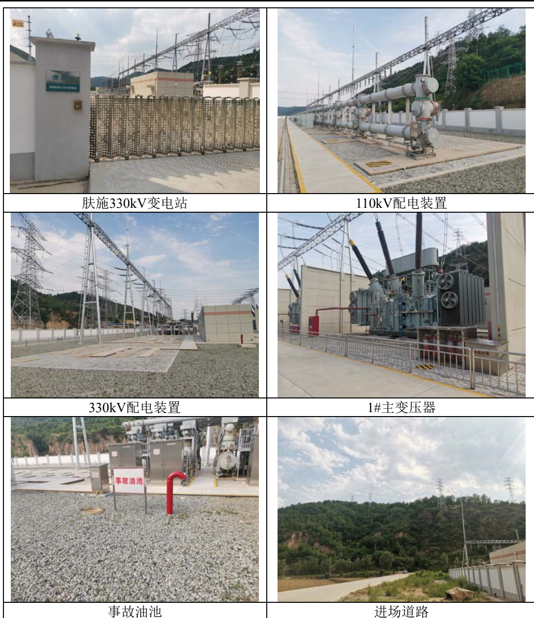
图2-1 肤施330kV变电站现状照片
