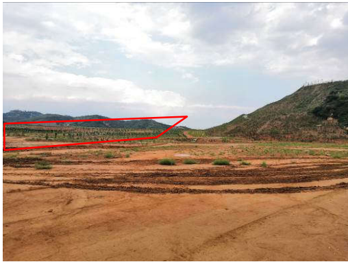
隔压站东北侧临时堆场
