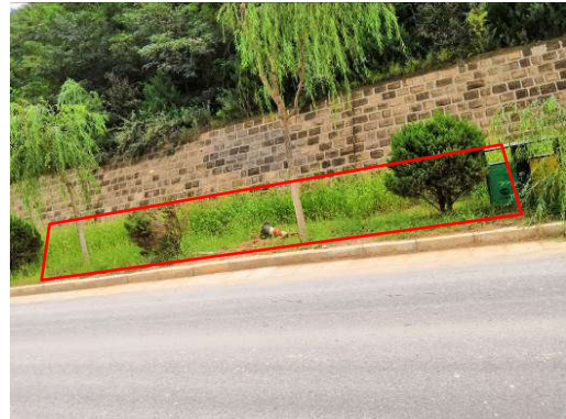
九标中间段恢复情况
