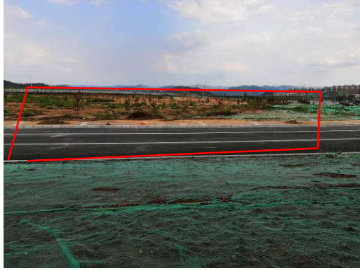
六标、七标、九标交汇处恢复情况
