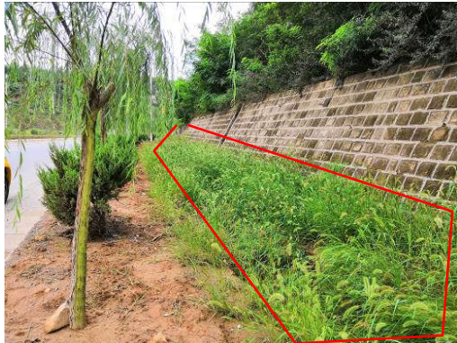
九标起点恢复情况
