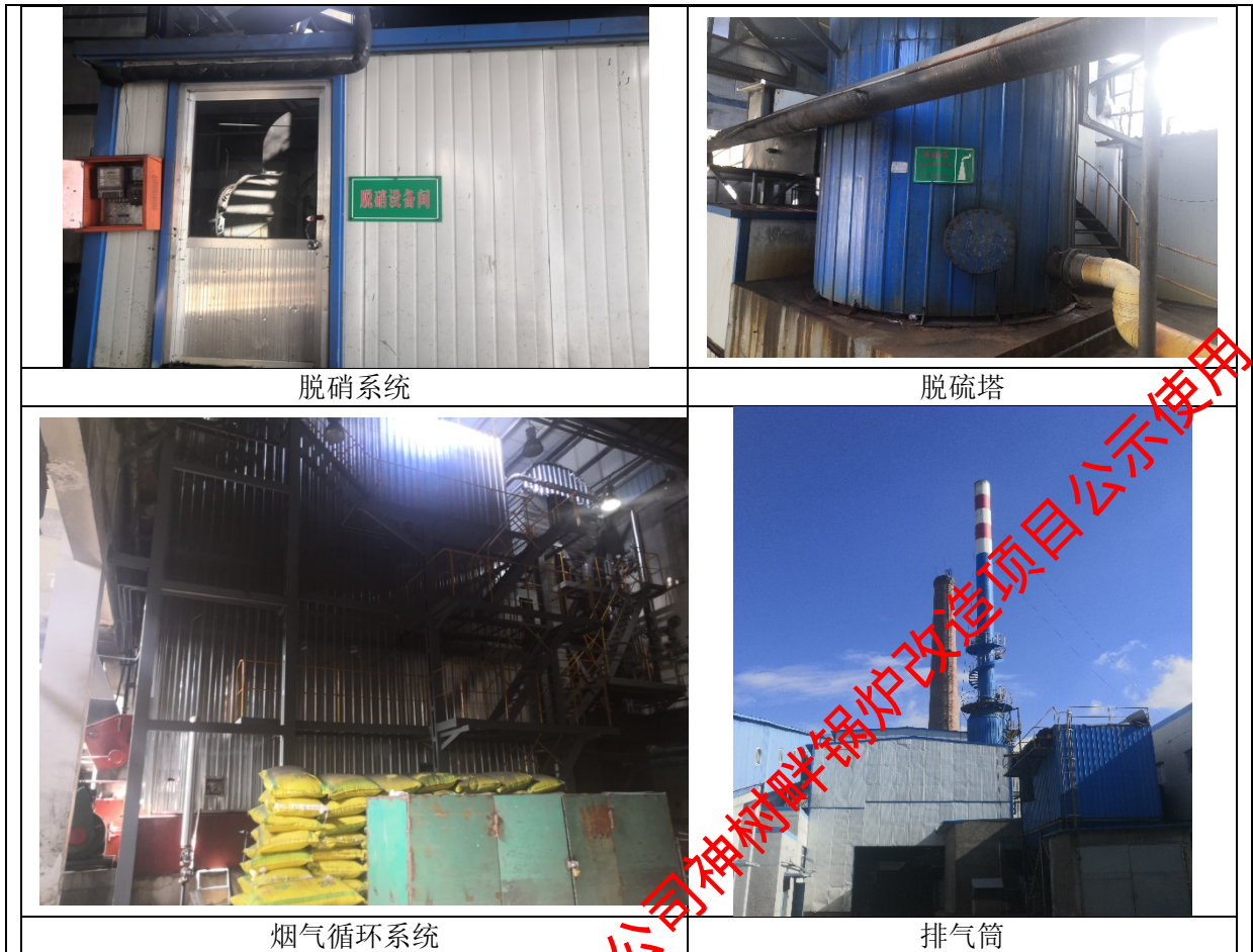
图 3-1 锅炉房及废气处理设施现场照片
