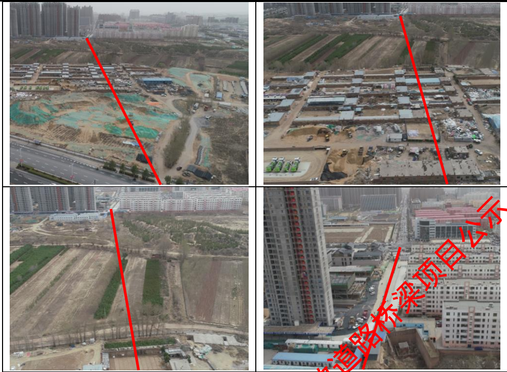
图 2-8 建榆路南延路段现状照片
