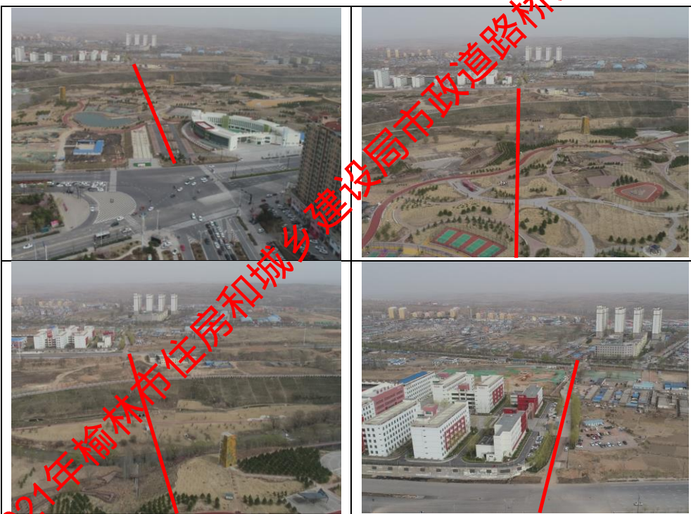
图 2-7 榆溪大道中段路段现状照片
