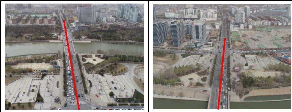
图 2-6 榆阳路加层桥路段现状照片
