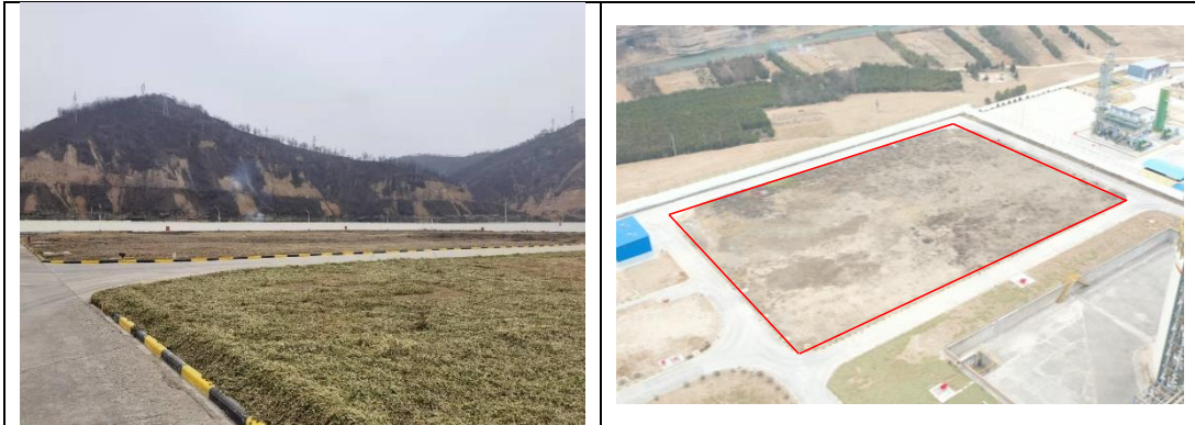
图 2-2 本项目拟建位置现状照片
